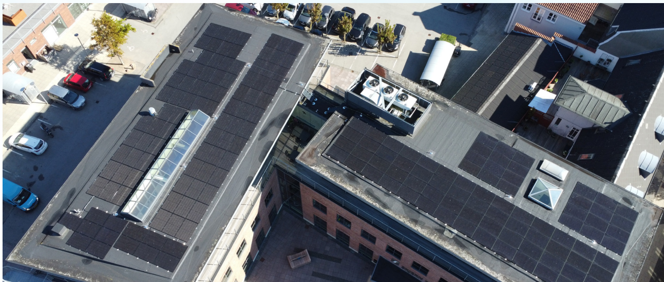
Taget af bankens hovedkontor i Skjern, hvor der er installeret solceller, som bidrog til 45 % af strømforbruget i 2025.
