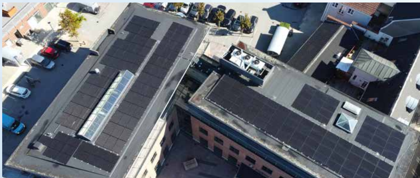
Taget af bankens bygning i Skjern, hvor der er installeret solceller.
